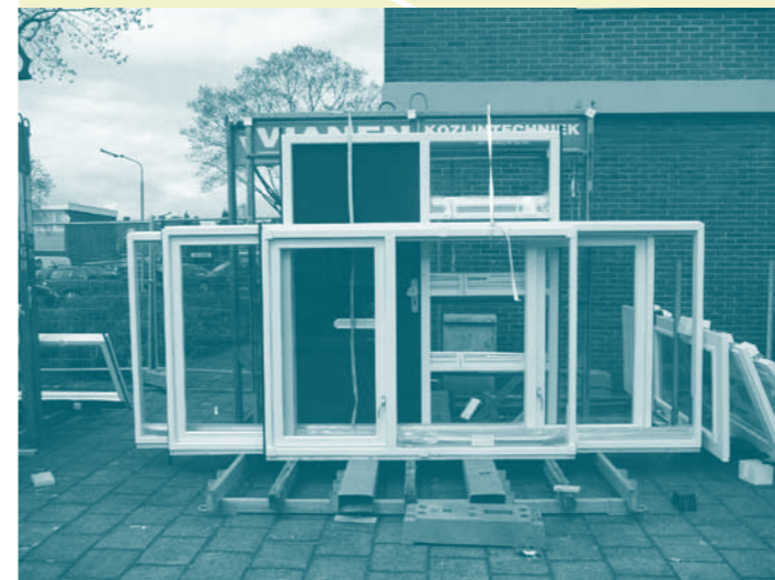
Een voordeur en kozijnen staan klaar om geplaatst te worden in een huis aan de Wattstraat.
